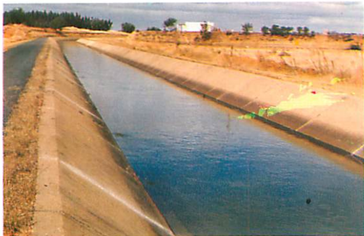
Canal de trasvase de aguas desde la Presa del Chanza a Huelva
