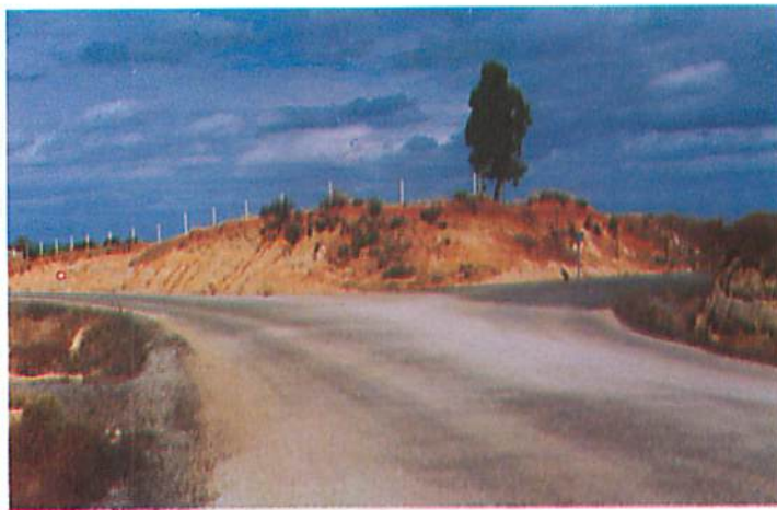
Camino de Castillejos y de Las Majadillas totalmente terminado
