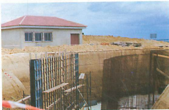
Estación de bombeo del sector 8 en fase de construcción, ubicada en el pareje de Cantargallo
