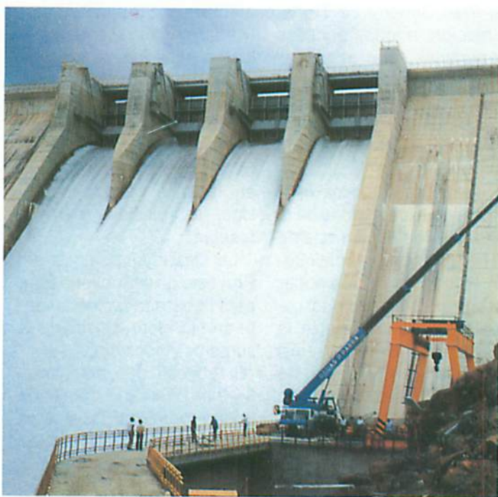
Presa del Chanza y central hidroeléctrica
