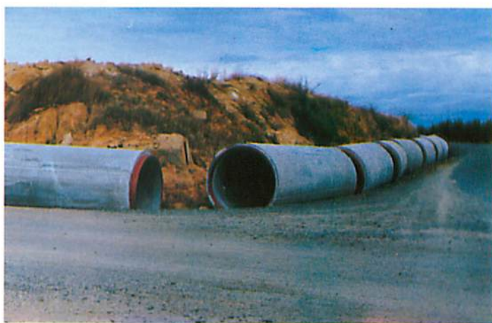
Conducción de abastecimiento a los sectores 8, 9, 10 y 11 en fase de instalación
