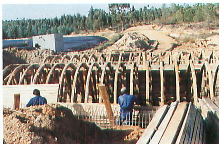
Puente de construcción al sitio del arroyo de la Sisera
