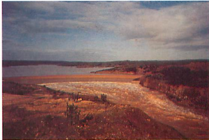
Presa de Los Machos aliviando
