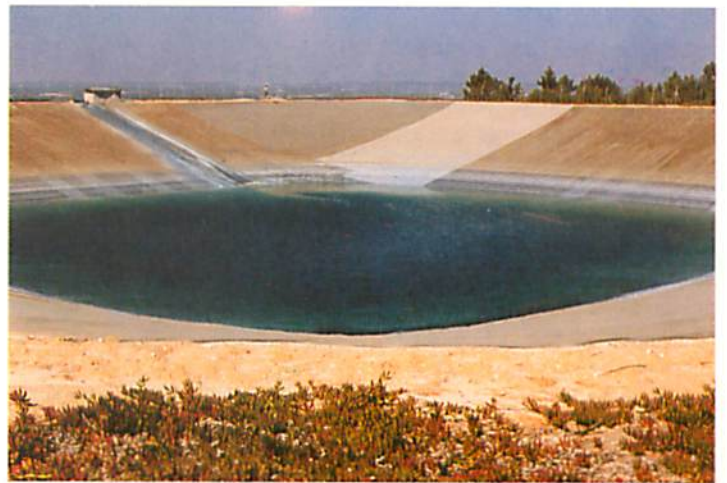
Balsa colectiva de regulación ubicada en Cabezareas
