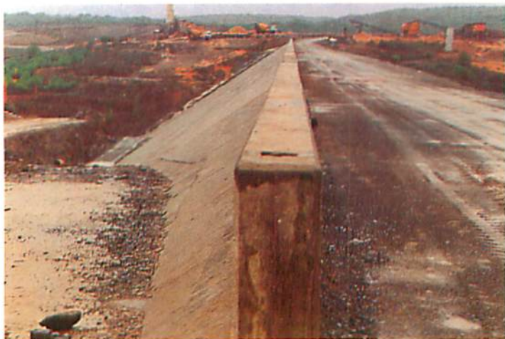
Presa de Los Machos en construcción
