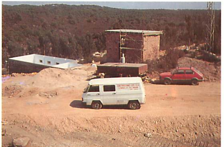
Obras del primer bombeo y estación transformadora de electricidad
