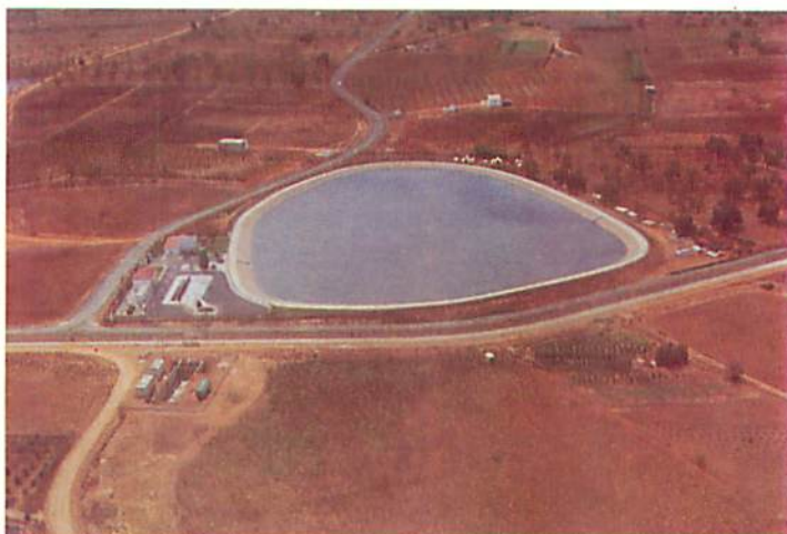
Balsa del sector 1 de la Zona Regable del Chanza y bombeo de la Zona Regable del Sur-Andévalo
