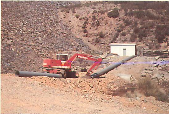
Conducción de toma de agua efectuada en una de las válvulas de desagüe de la Presa de los Machos
