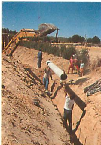
Instalación de conducciones
