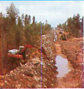
Portada: Obras de riego en precario Foto archivo de la Comunidad de Regantes de Lepe
