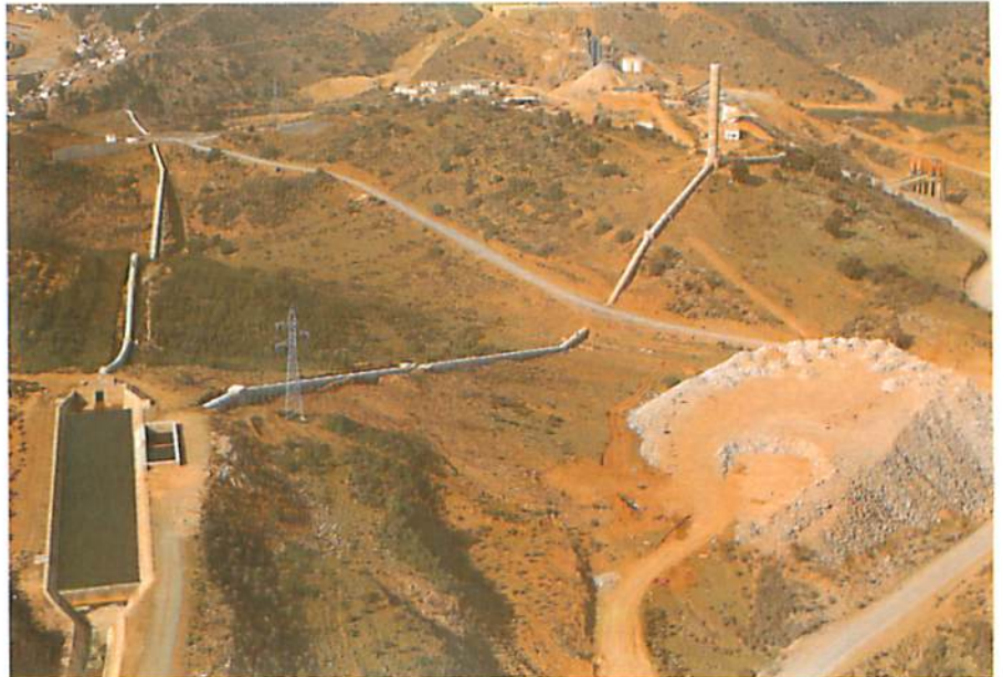
Bombeos del Chanza al Canal
