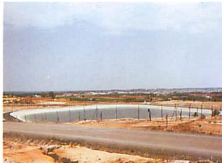
Balsa de regulación de los sectores 8 y 9
