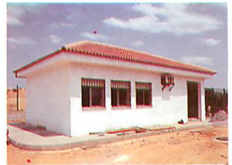
Caseta de control
