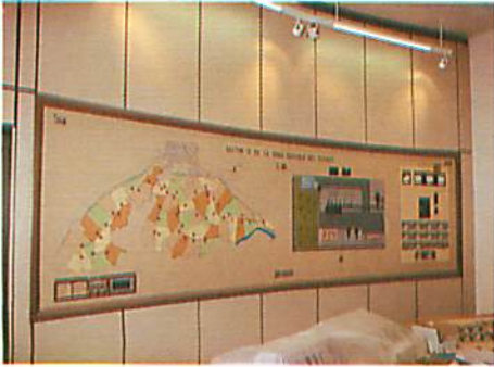
Cuadro de control de riego
