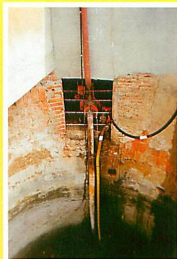
A la izquierda, rodillo de la noria donde se ubicaban los cangilones que sacaban el agua. A la derecha, motor instalado en galería para extraer el agua de pozo "a cielo abierto"
