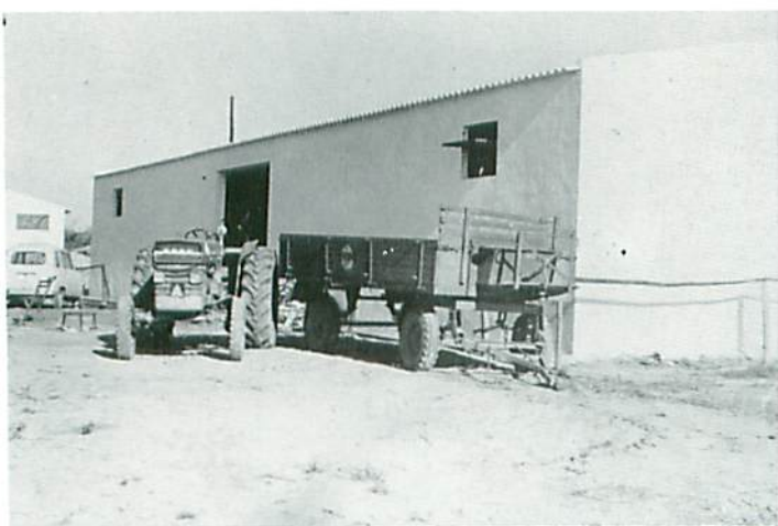
Primer tractor y remolque junto a la también primera nave construida
